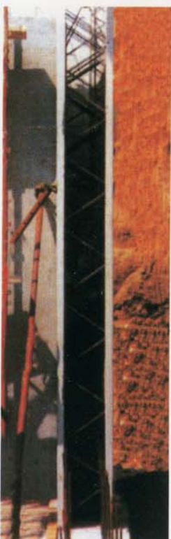
Fase di posa
